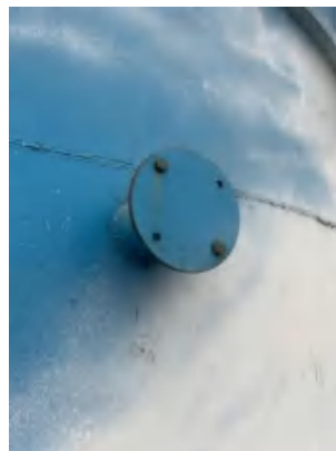
P4 连铸废气、钢包维修废气、火焰切割废气、上料废气采样口
